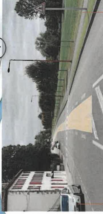
Trottoir large transformé en voie verte, puis à l'approche du pont remaniement de la chaussée en supprimant la bande centrale et intégration d'une piste cyclable
