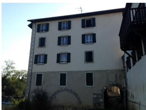
Moulin sur la Bidouze transformé en logements
