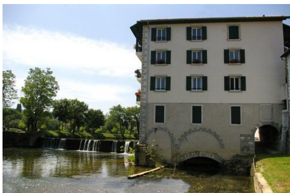
Moulin sur la Bidouze actuellement reconverti en logements
